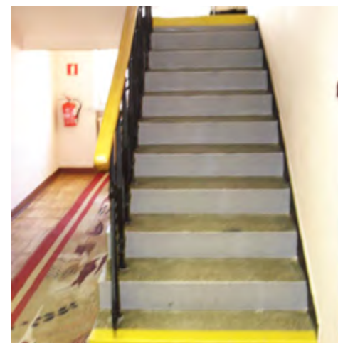
Oznaczenie schodów w sposób kontrastowy (żółta taśma na pierwszym i ostatnim stopniu) ułatwia osobie słabowidzącej ich zlokalizowanie oraz bezpieczne pokonywanie.
